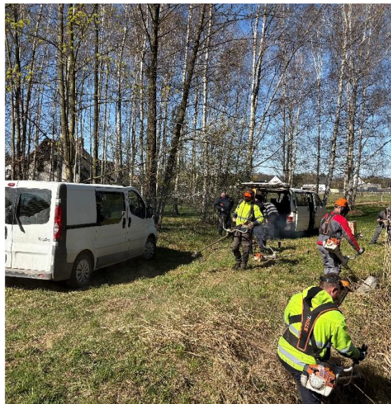
Koszenie i pogłębianie rowów melioracyjnych kwiecień 2025
